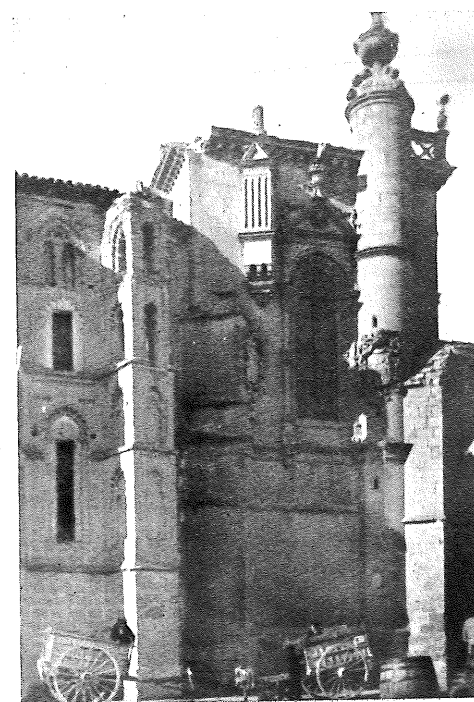
Fot. 2.—Convento de San Pablo. Torre del Caracol.
